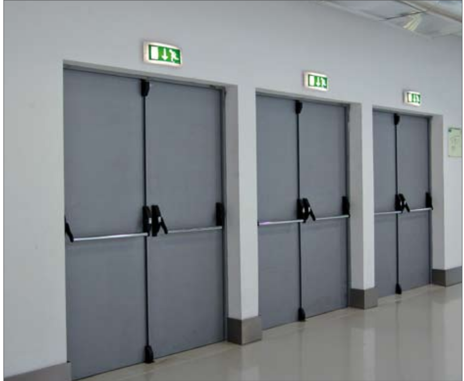
↘ As portas corta-fogo são um elemento fundamental na segurança contra incêndios. As barras anti-pânico têm como objectivo facilitar a abertura manual das portas numa situação de emergência.
