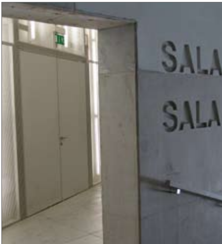
↘ A Casa da Música, no Porto, é uma das obras emblemáticas onde estão instaladas portas da Porseg.
